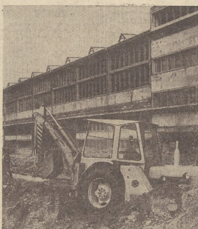
W Kielcach buduje się Zakład Naprawczy Silników Wysokoprężnych, w którym za rok remontować się będzie 5 tys. silników tego typu z całego kraju. Koszt tej inwestycji wyniesie około 40 milionów złotych.
