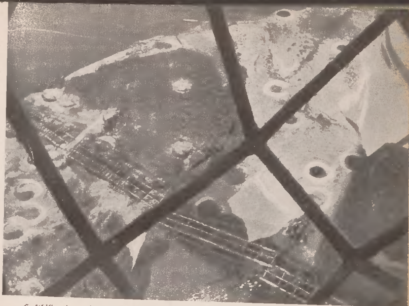
Luftbild einer Holzbrücke, die im Feuer der Kampfflieger in Flammen aufgegangen ist. Auf der Insel sind zahlreiche Bombeneinschläge zu sehen
