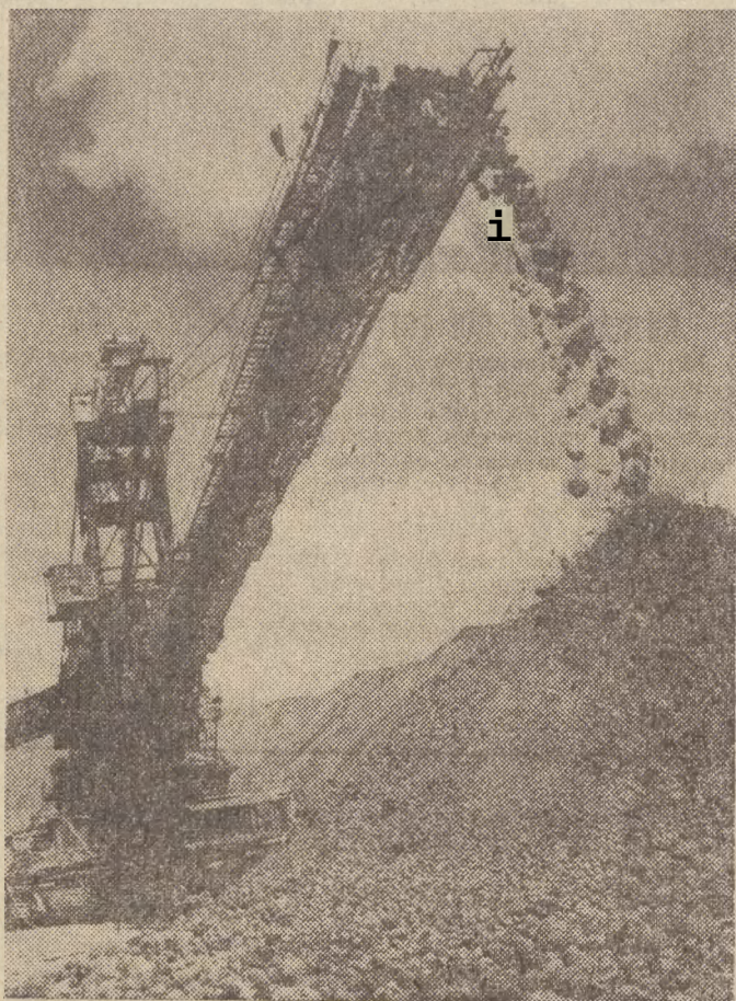
Każdego dnia z odkrywek Turów I i Turów II olbrzymie ciężkie koparki kroczące, taśmociągi i zwałowarki wydobywają setki ton węgla brunatnego. Jego najbliższa droga wiedzie do elektrowni Turów. Turoszowskie brunatne skarby wysyłane są wagonami również do NRD. CAF — Wołoszczuk
