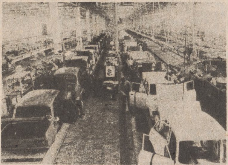
Hala montażu moskwiaków 412 w zakładach „Balkan” w Łowczu (Bul- garia).
