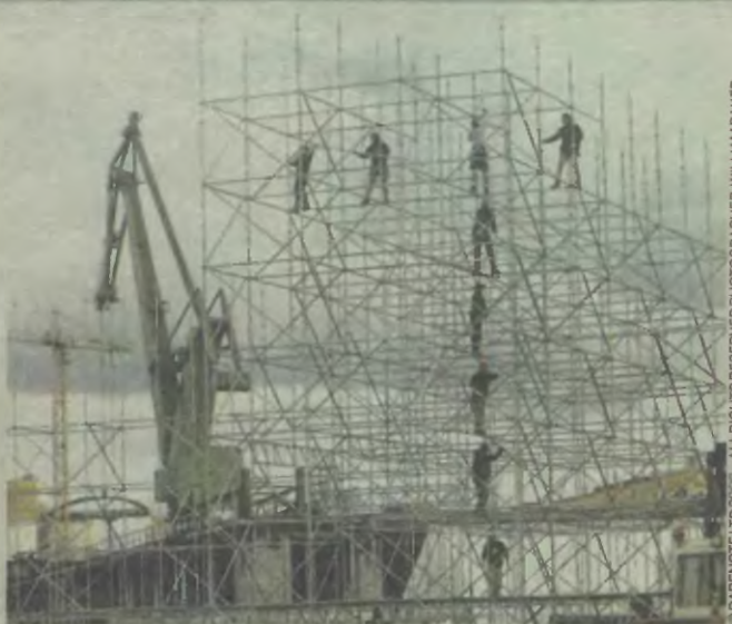
Ustawianie wież, na których będzie oświetlenie sceny
