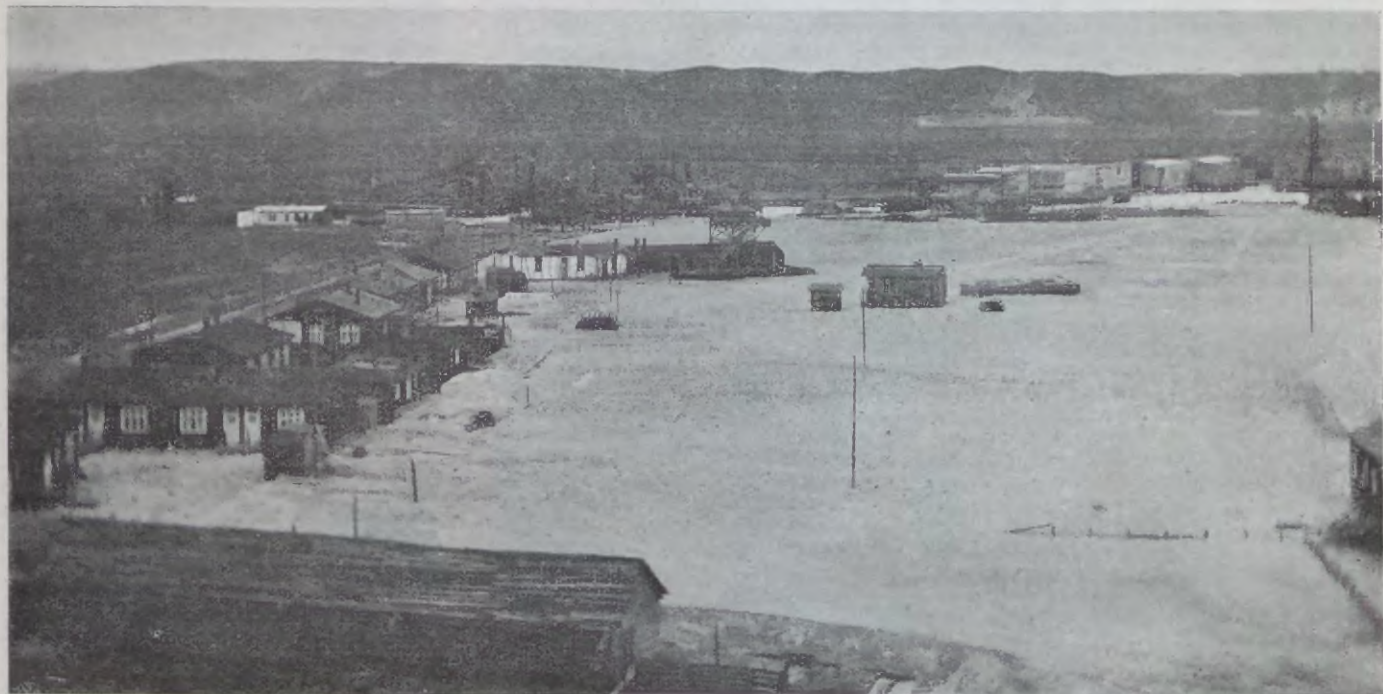
Z lewej strony widać statki taboru pogłębiającego. W środku obok kanału żelbetowe skrzynie do nabrzeży. Z prawej zapoczątkowane roboty przy
