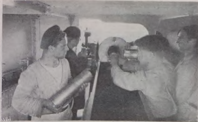
Flotyłłapińska: Na monitorze polskim „Toruń”. Artylerja w wieży monitora podczas strzelania. Nabój składa się z dwóch części: pocisku, który został włożony, i gilzy z substancją wybuchową.
