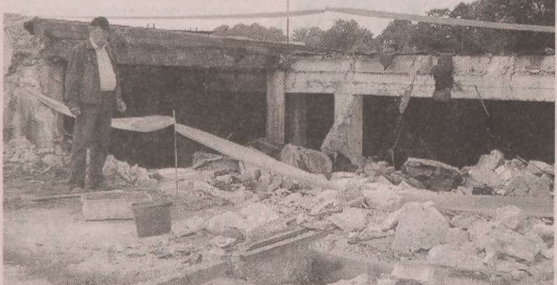
Na zdjęciu: Rozbiórka dawnego składu opalowego przy ulicy Wybickiego w Miastku.
