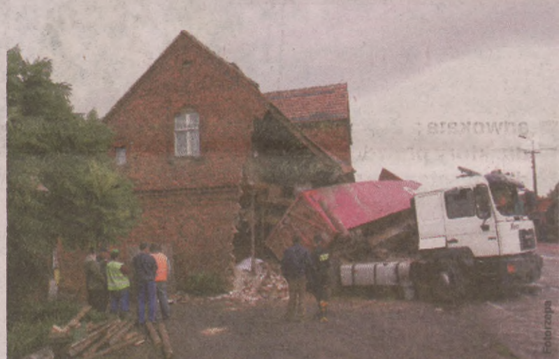
Na zdjęciu: W miejscowości Ponin koło Kościana (woj. wielkopolskie) wczoraj rano, ok. godziny 5.20 samochód ciężarowy uderzył w dom mieszkalny. Zginęły dwie osoby, mieszkańcy domu.
