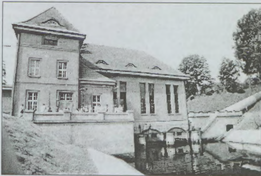
Budynek elektrowni w Bielkowie. Widok od dolnej wody
