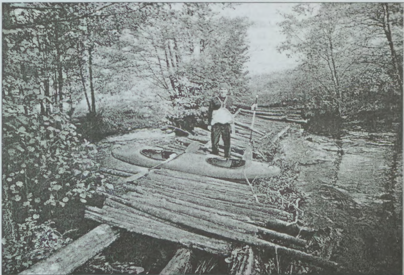
Zniszczona kładka na dolnym odcinku Studnicy, tuż przed ostatnim przełomem
