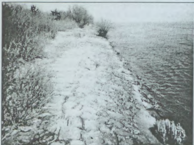
Opaska hydrotechniczna pomiędzy rezerwatem „Mewia Łacha” a Przekopem Wisły
