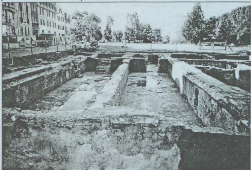
Odsłonięte fundamenty Domu Krółów latem 2003 r.
