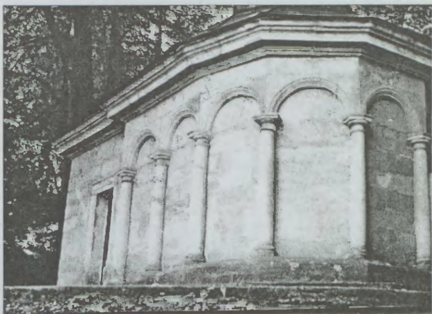
Elewacja północno-wschodnia kaplicy Grobu Chrystusa w Kalwarii Wejherowskiej
