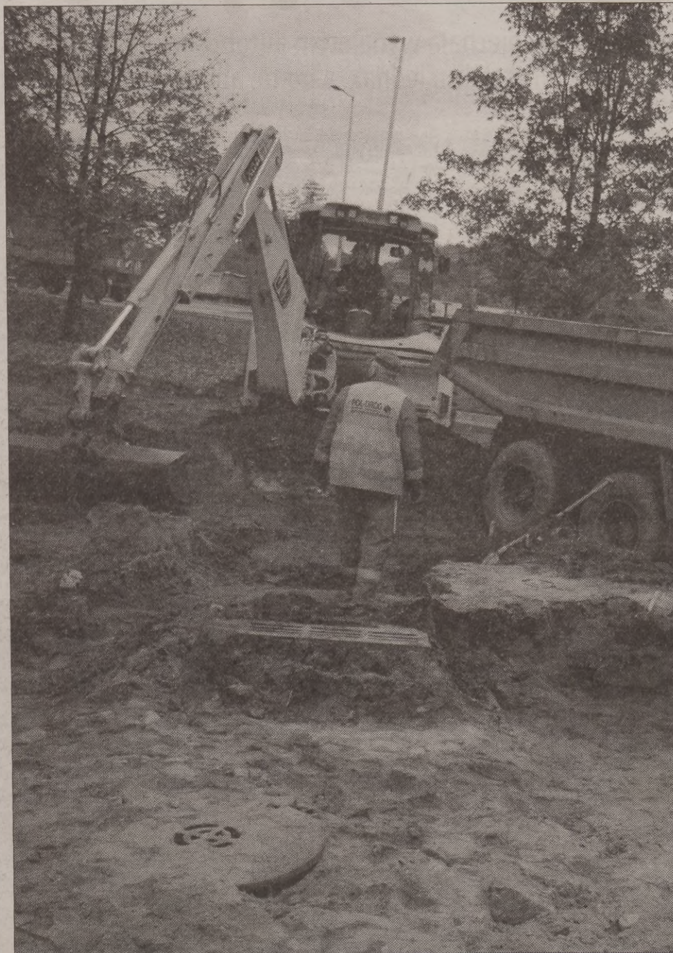
Rozpoczęła się budowa nowego ronda.
