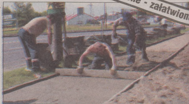
Ekipy remontowe naprawiają chodnik przy ul. Szczecińskiej. Fot. Kamil Nagórek
