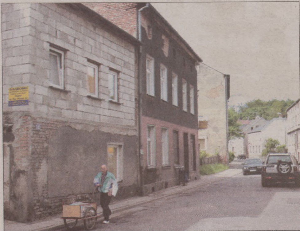
Mieszkańcy ulicy narzekają na fatalny stan techniczny kamienic i wąskie chodniki.
