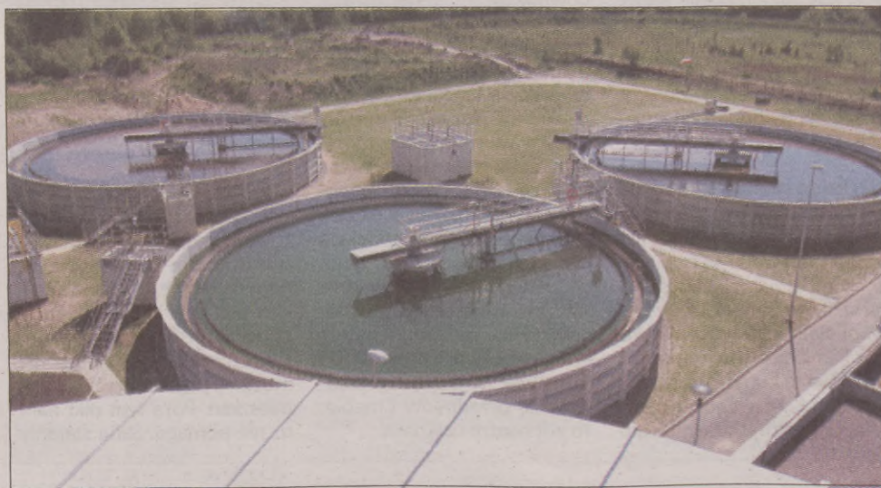
Nowa oczyszczalnia ścieków w Ustce.
