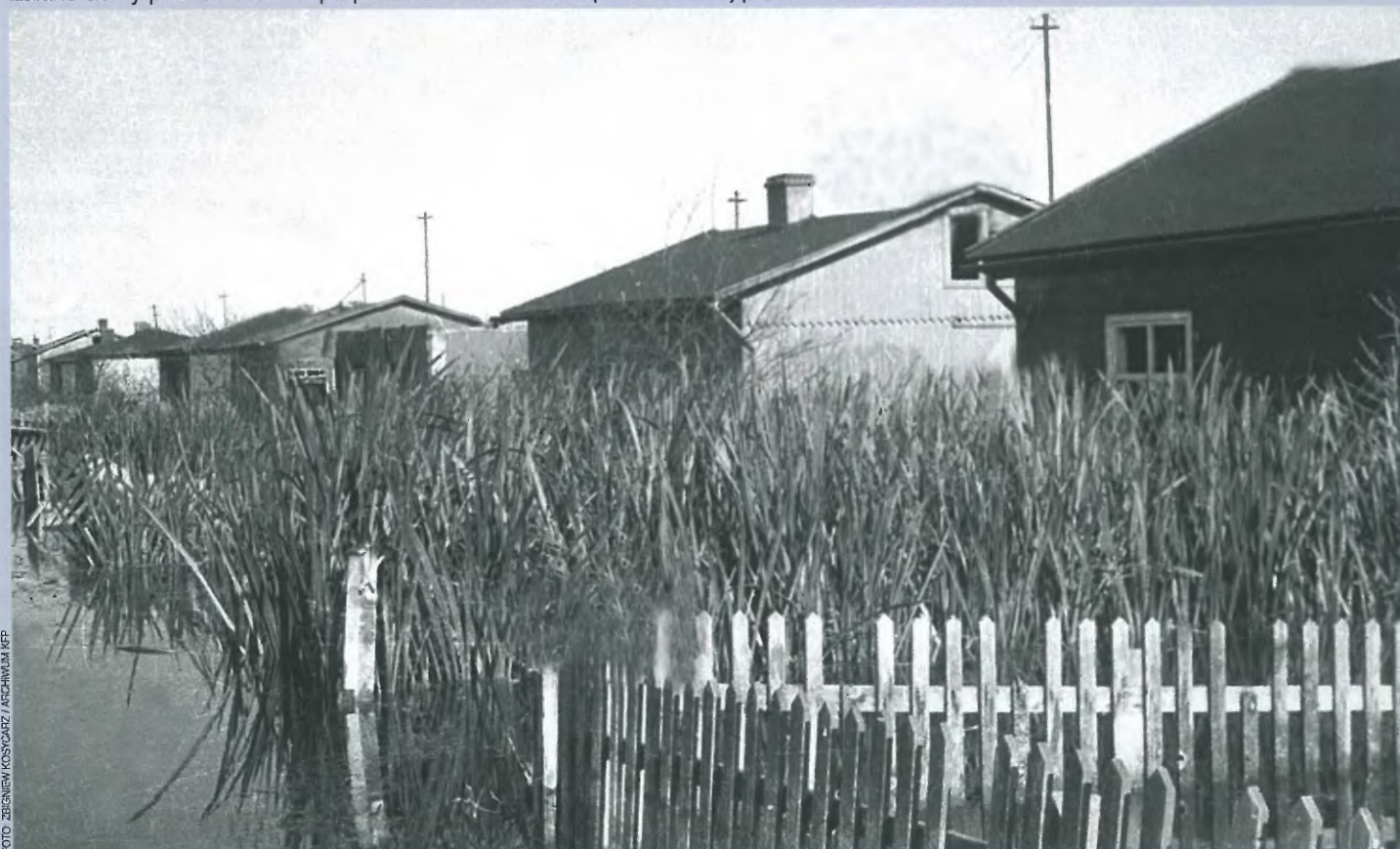
Zalane domy pod Gdańskiem po powodzi na Żuławach spowodowanej przez Niemców w 1945 roku
