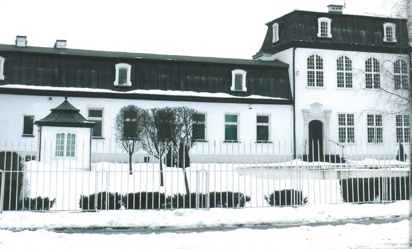
Dwór przy ulicy Piecewskiej został odbudowany
