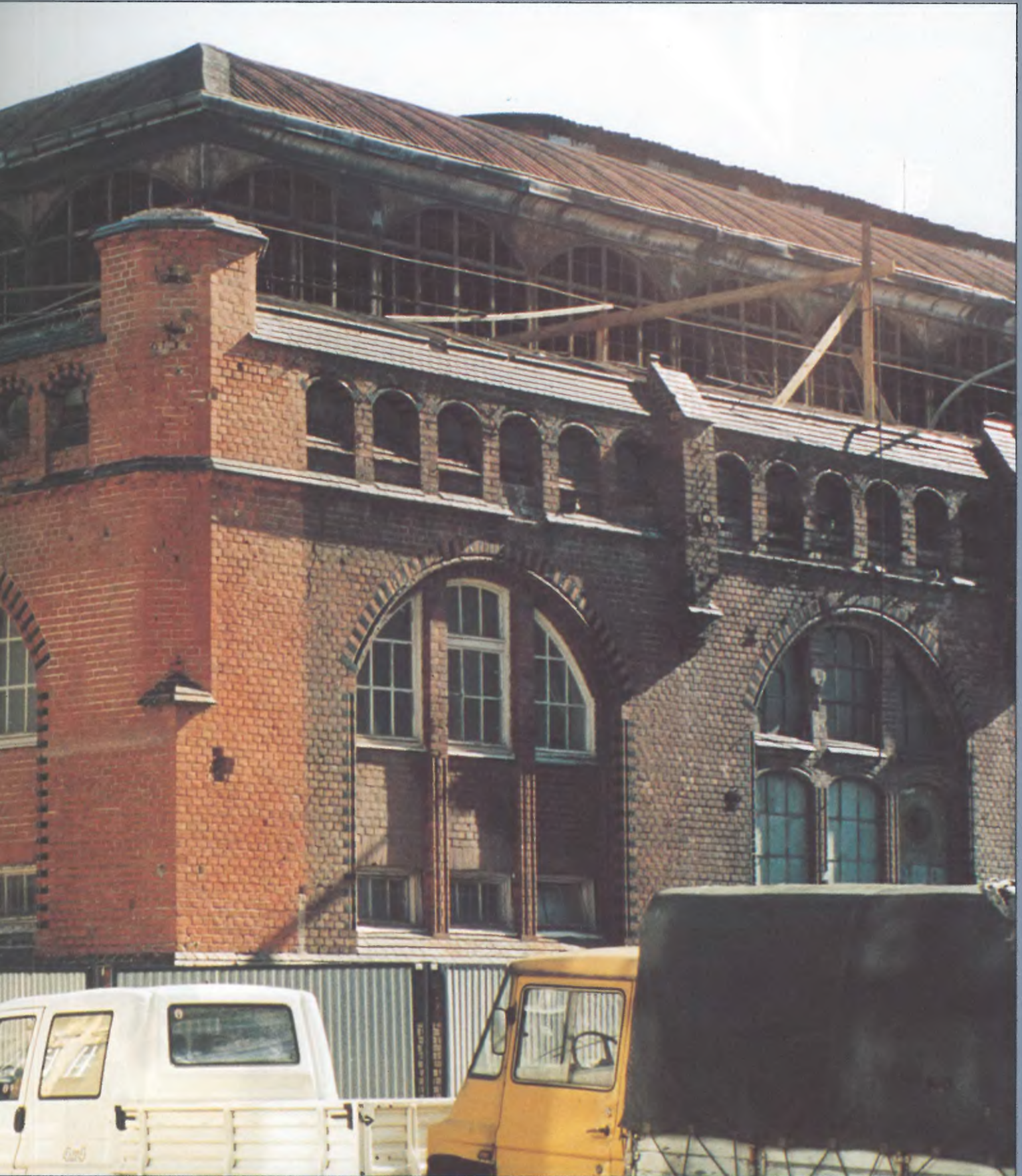
Przy Hali Targowej prowadzone są prace konserwatorskie. Będzie też modernizowana
