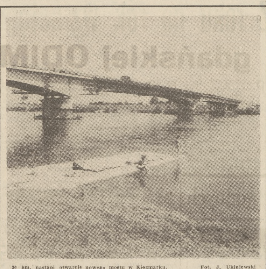
20 km. nastąpi otwarcie nowego mostu w Kiezmarni. Fot. J. Uklejewski
