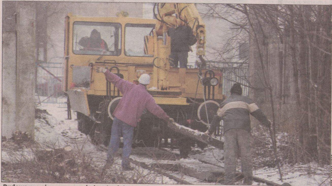
Budowa prowizorycznego skrótu. Jezdnia ma mieć 6 m szerokości, a chodnik z kostki 2 m.
