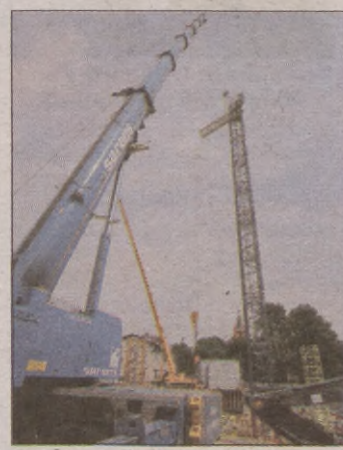
Budowa Galerii Słupsk.
