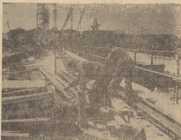
Pod potężny dźwig bramowy o udźwigu ponad 800 ton montuje się specjalne szyny prowadzące udołu suchego doku.
