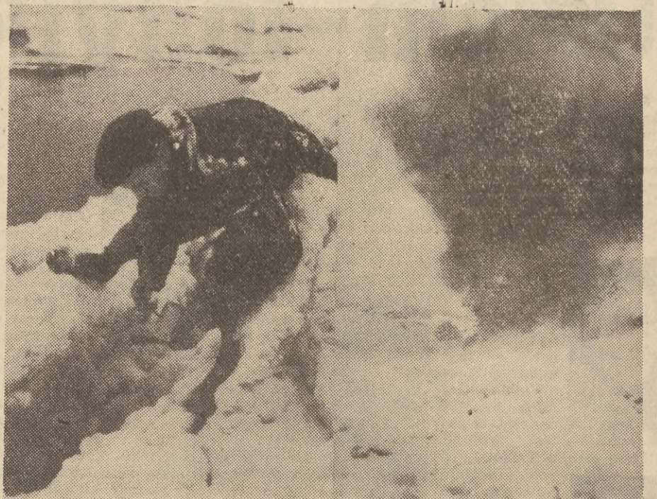
Na zdjęciu z lewej: zakładanie ładunków wybuchowych. Na zdjęciu z prawej: wybuchy ładunków kruszą lód.
