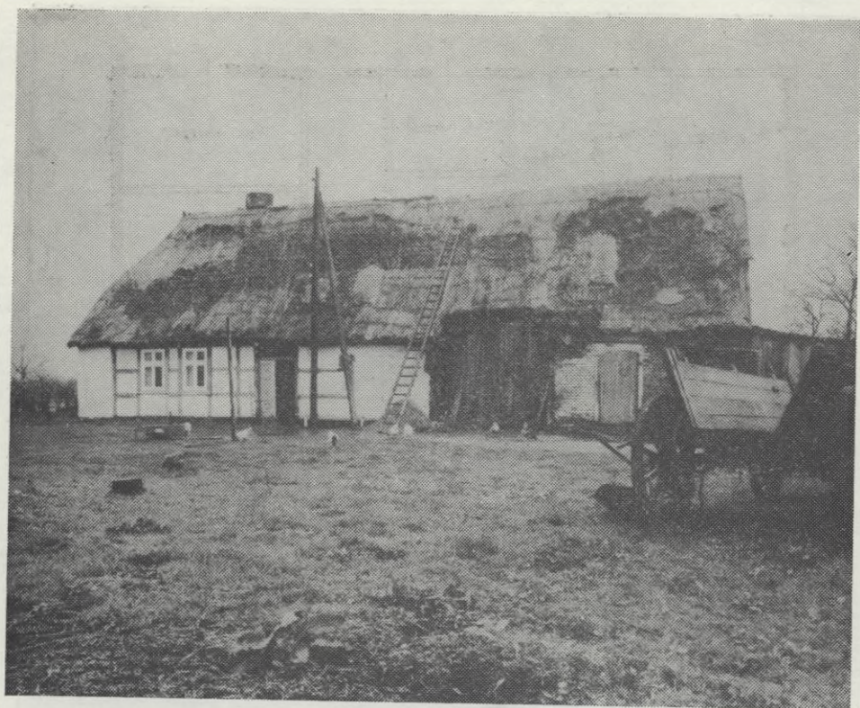
Ryc. 5. Grzybowo, gm. Kołobrzeg. Budynek mieszkalno-gospodarczy nr 28. Wł. Wojciech Szczęściwilk. Widok od podwórza. Fot. Grzegorz Solecki
