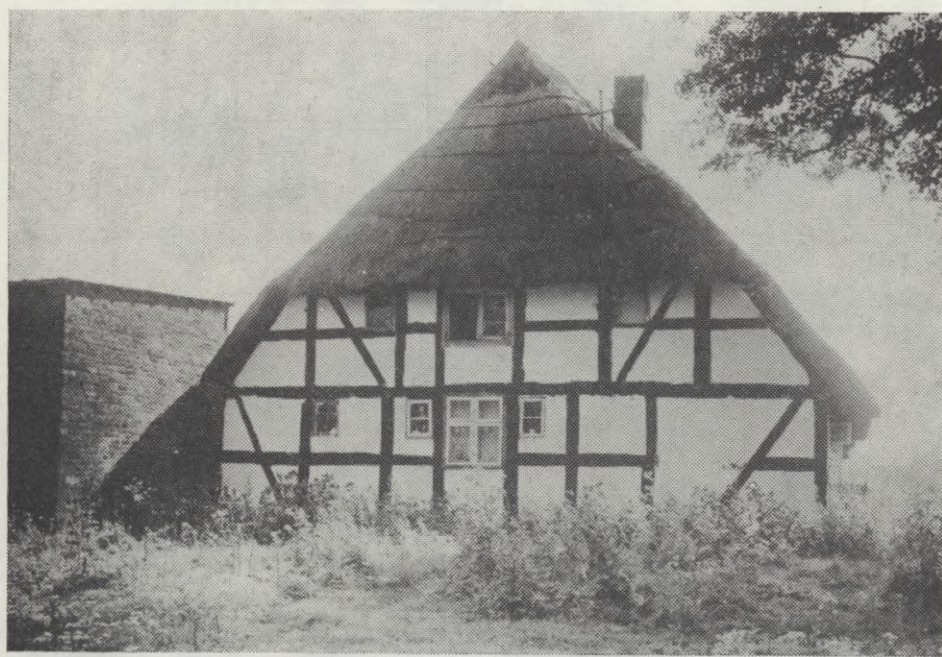
Ryc. 25. Dąbki, gm. Darłowo. Chatupa z zagrody nr 23. Wł. Edward Szymczyk. Widok na ścianę szczytową — dawną frontową. Fot. Grzegorz Solecki
