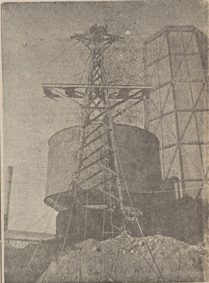
Budowa kolejki linowej między kopalniami „Chrobry”, „Mieszko”, „Wiktoria” i „Thorez” w Wałbrzychu ma na celu usprawnienie transportu różnych typów węgla wg jakości do odpowiednich zakładów koksowniczych.
