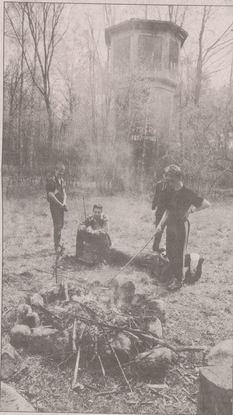
Na dawnej stacji rozjazdowej będzie stacyjka rowerowa Gabel
