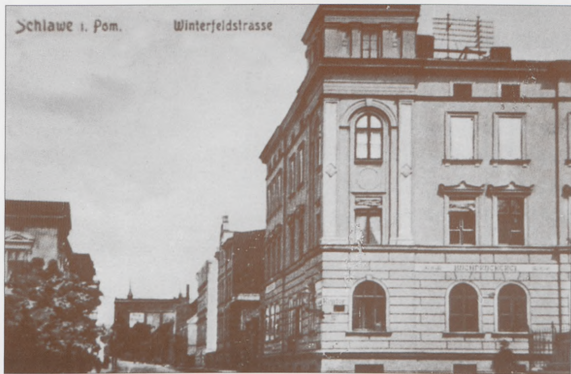
Pocztą i widok na obecną ulicę I Pułku Ułanów. Pocztówka z początku XX wieku. Post und Blick in die Winterfeldstr., heute I. Pułku Ułanów.
