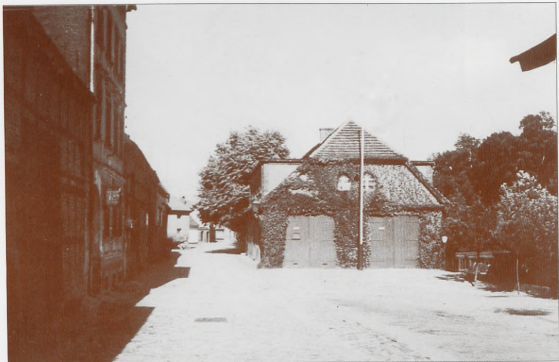
Ulica Basztowa i budynek straży pożarnej. Zdjęcie z początku wieku. Str. ul. Basztowa mit Gebäude der Feuerwehr, Anfang des 20. Jh.
