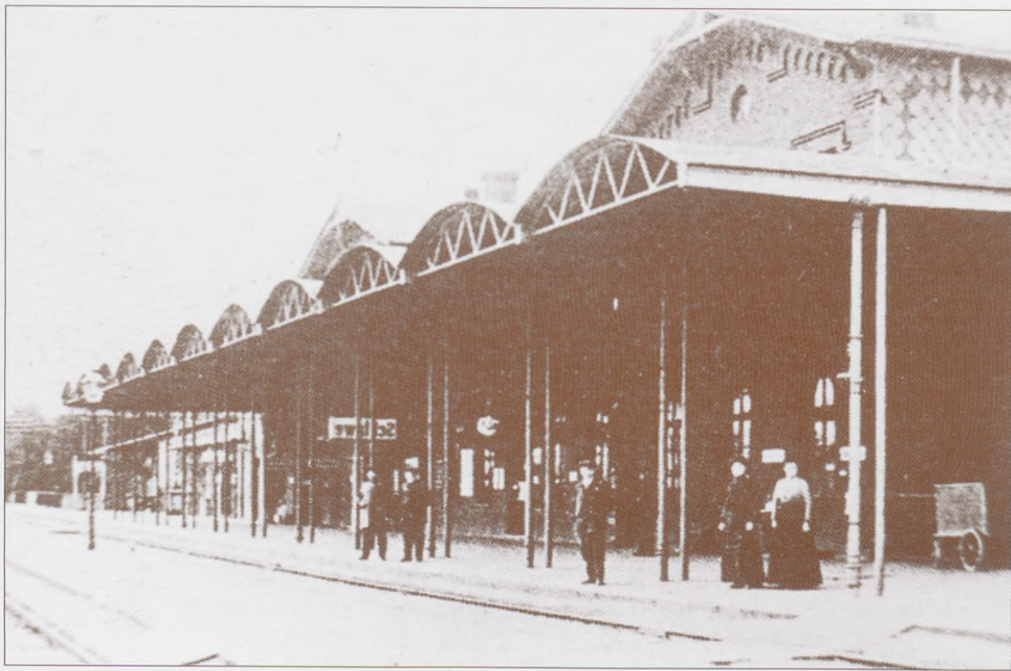
Peron na sławieńskim dworcu kolejowym. Zdjęcie z początku XX wieku. Bahnsteig des Schlauer Bahnhofs, Anfang des 20. Jh.
