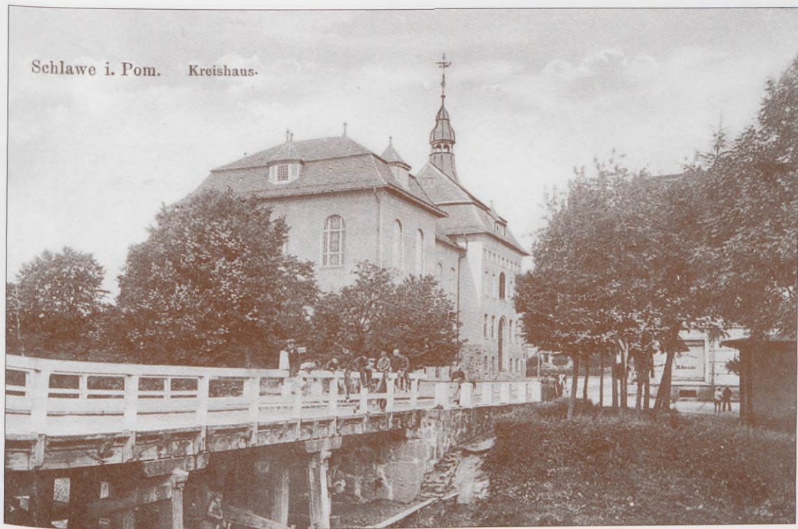
Drewniany most na Moszczenicy i Starostwo. Zdjęcie z lat 10-tych XX wieku. Holzbrücke über die Motze und Landratsamt, 1900.
