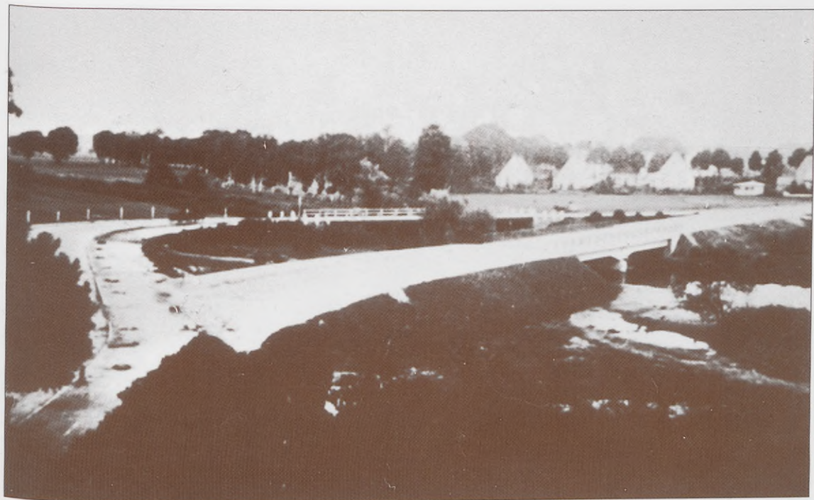
Budowa nowego mostu na Wieprzy (na obecnej ulicy Gdańskiej). Bau der neuen Wipperbrücke, Stolper Vorstadt, heute ul. Gdańska.
