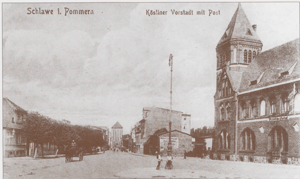
Budynek poczty z widokiem na Bramę Koszalińską. Zdjęcie z lat międzywojennych. Postamt und Blick auf das Kösliner Tor, Vorkriegsfoto.
