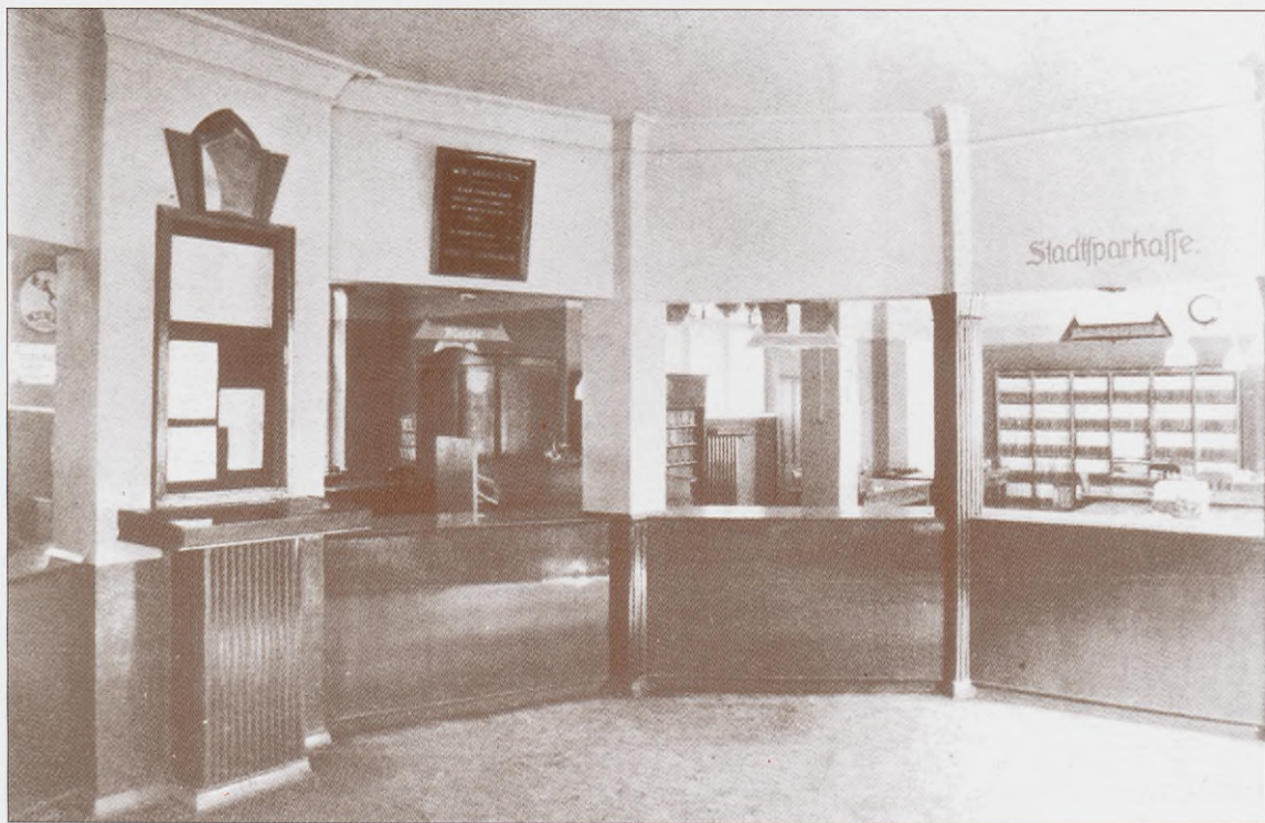
Wnętrze Stadtparkasse. Zdjęcie z lat międzywojennych. Kassenraum der Stadtparkasse, Vorkriegsfoto.
