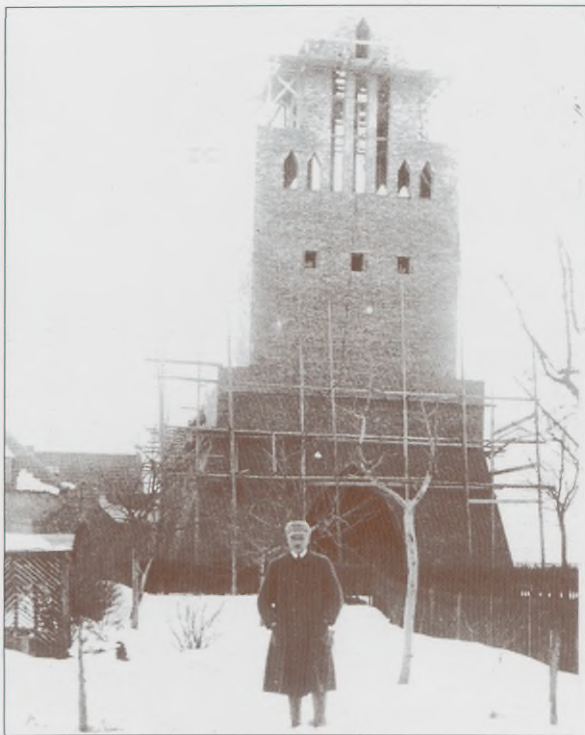
Kościół św. Antoniego w budowie. Zdjęcie z 1926 roku. Kirche des hl. Antonius im Bau, 1926.
