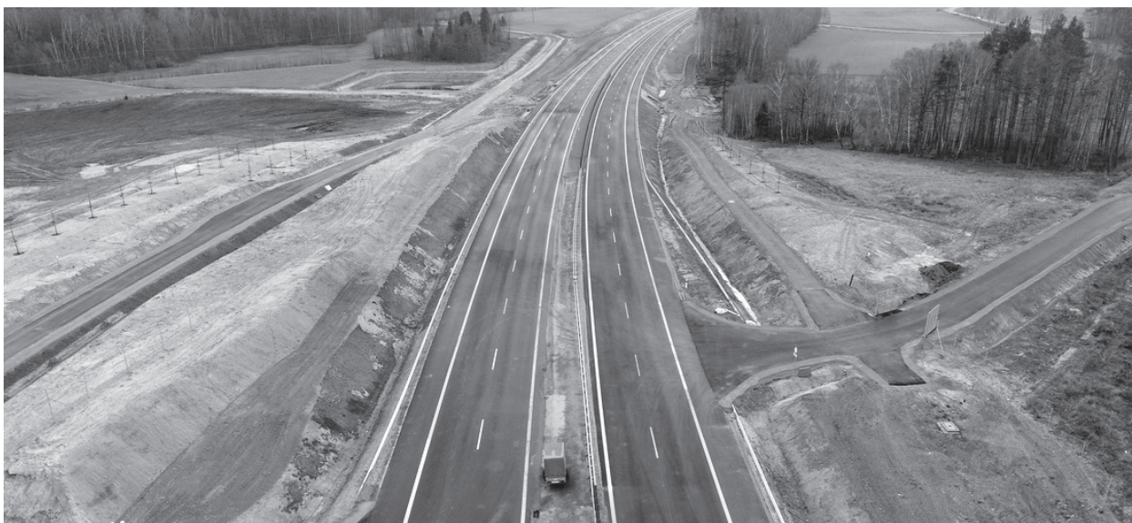
Budowa drogi ekspresowej S6 w województwie pomorskim Fot. Generalna Dyrekcja Dróg Krajowych i Autostrad Oddział w Gdańsku
