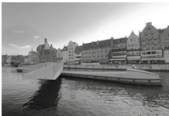
Obrotowa kładka na Motławie. Fot. SL
