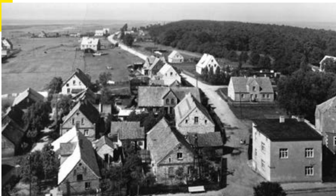
Dom Dawida Długiego (pierwszy od lewej), w którym mieszkał Jerzy Bandrowski, na pocztówce z lat sześćdziesiątych. Budynek istnieje do dziś
