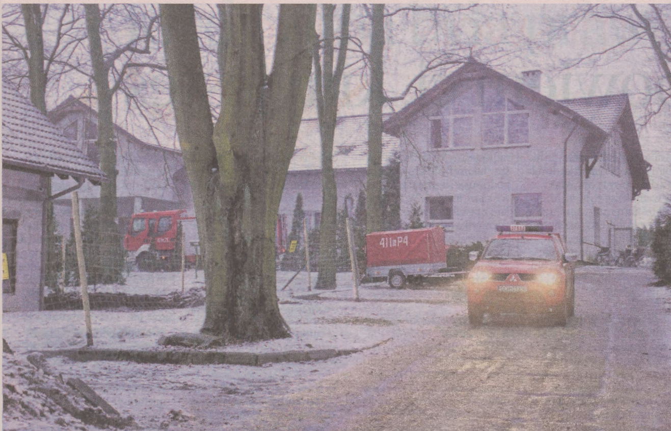
Budynek hospicjum po pożarze nie wygląda najgorzej, ale duże zniszczenia są w środku. Jest konieczny duży remont
