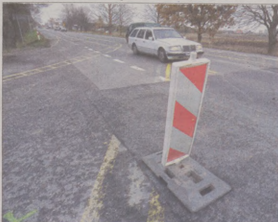
Wójt Kobylnicy zapowiada, że niewyremontowanej drogi nie przejmie od GDDKiA.
