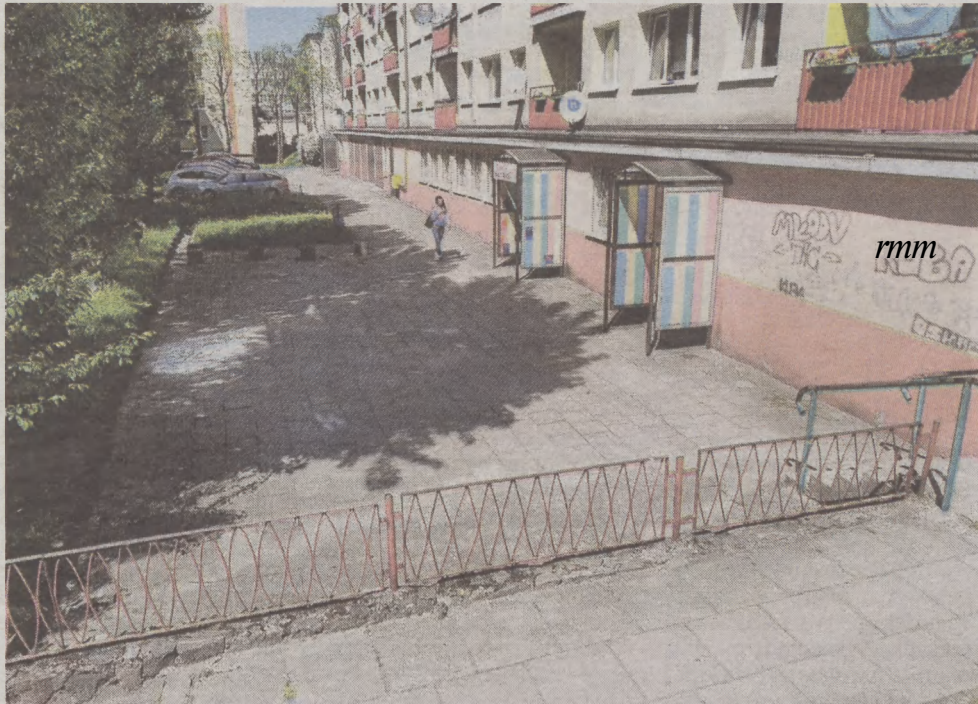
Podwórko przy ul. Wiejskiej 8 w Słupsku od dawna czeka na remont
