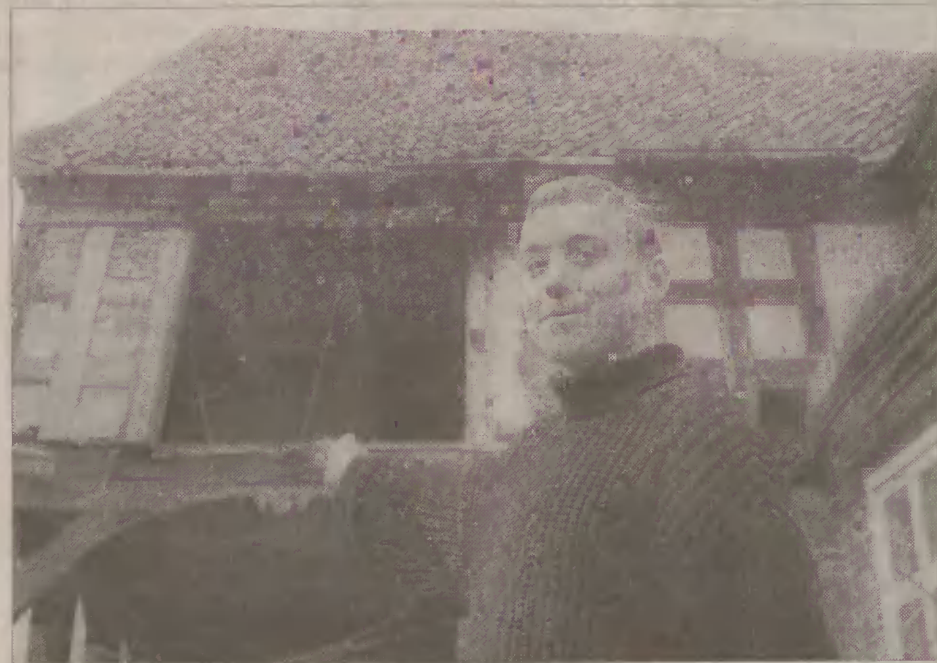
- W ubiegłym roku wypadła część muru podcienia - wspomina Andrzej Senderski.
