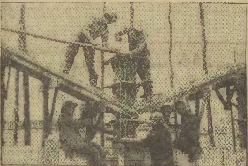
Brygada cieśli Brunona Milera w czasie szalowania podciągów pod dźwigi stołowe OHP w Złotej Karczmi.
