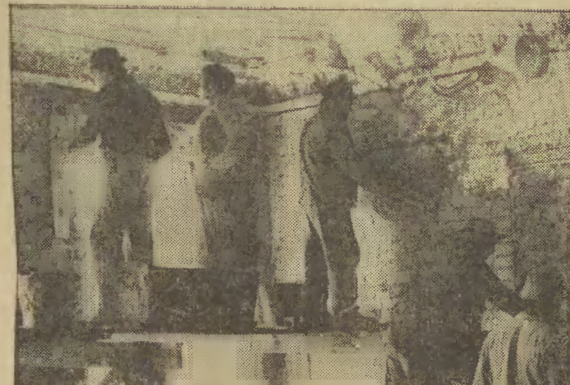
Kapitałny remont budynku mieszkalnego przy ul. Słuz 2 wykonują brygady tynkarsko - murarskie Bernarda Szmidtke i Stanisława Jedela
