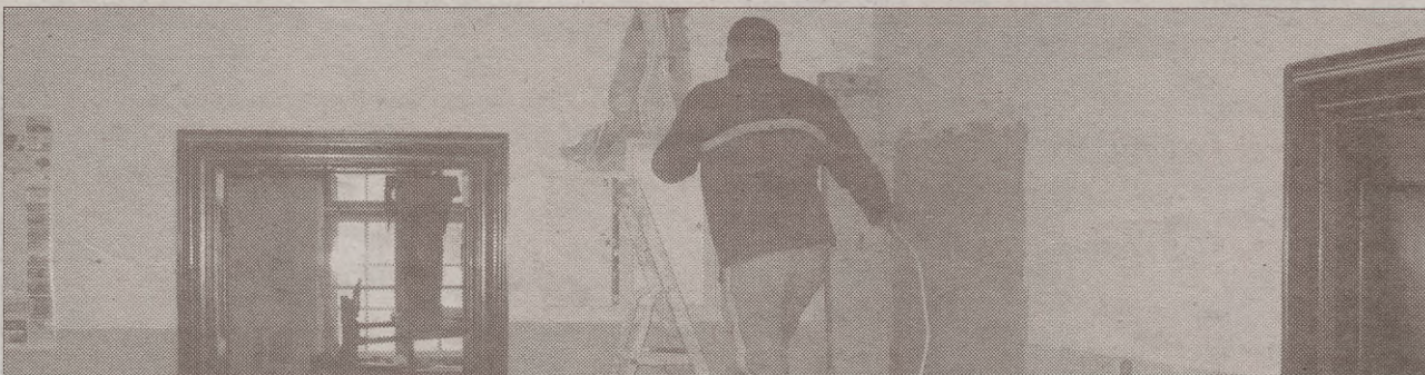
W ubiegłym roku remontowano ratusz wewnątrz. Teraz wymieniony zostanie dach.
