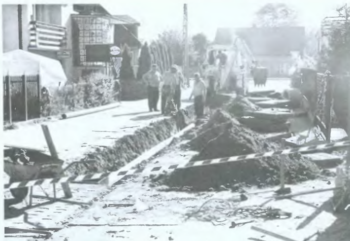
Budowa odwodnienia ul. Kruczej w Bolszewie
