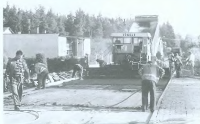
Budowa ul. Leśnej w Bolszewie
