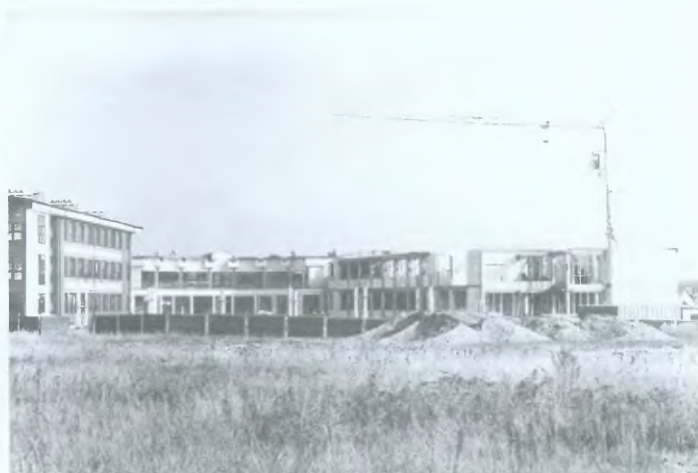
Coraz bardziej zaawansowana jest budowa drugiego pawilonu dydaktycznego B2 gimnazjum w Bolszewie
