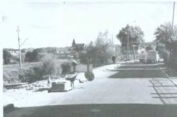
Budowa chodnika na ul. Słonecznej w Gościcinie
