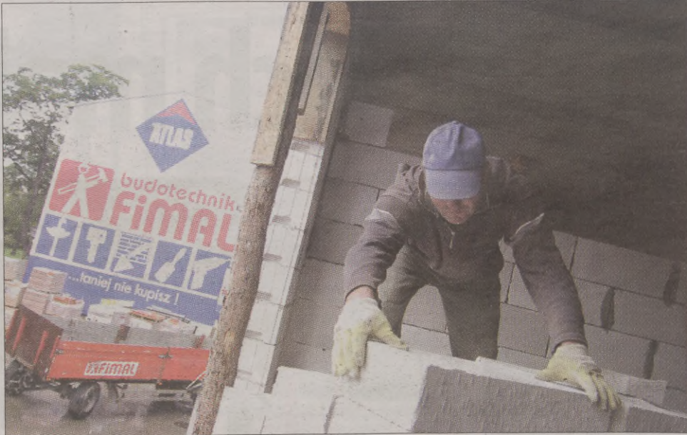
Budowa nowego salonu sprzedaży spółki Fimal.
