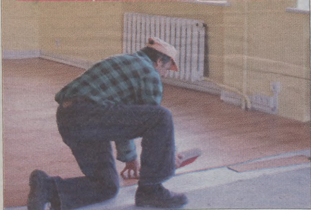
Przechlewscy radni zasiadają na początku października w nowej sali obrad. Wymieniana jest podłoga, malowane są ściany. Sala wyposażona zostanie w nowe stoły, krzesła i inne meble.
