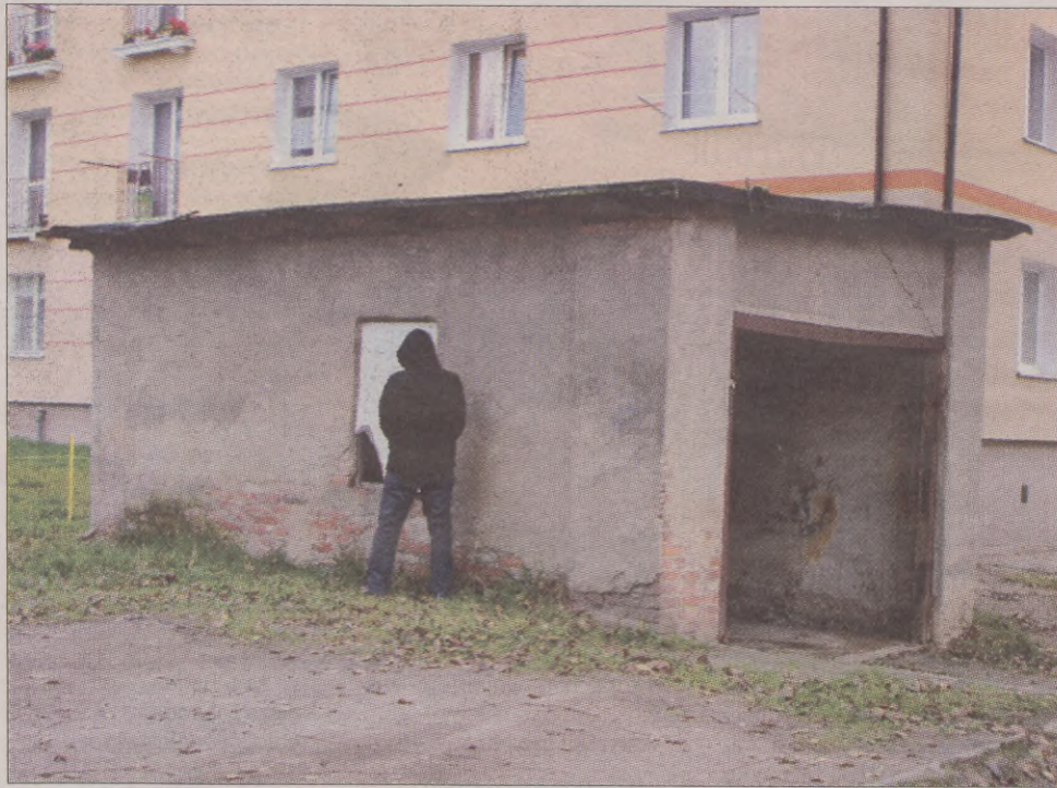
Garaż w Redzikowie na tle wyremontowanych bloków.
