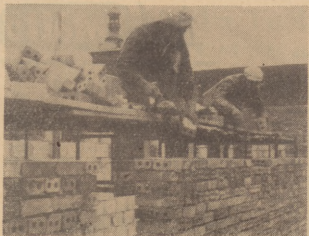
Warsztaty szkolne przy ul. Aksamińskiej są jeszcze w proszku, może to zdjęcie przypomni wykonawcy — MPRB nr 1 — o wciąż nie zrealizowanych terminach.
