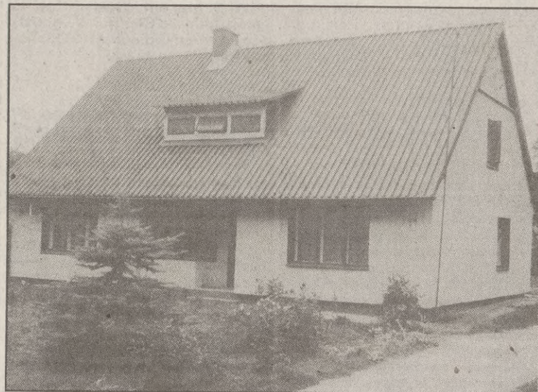
Zmodernizowany budynek mieszkalny w nagrodzonej zagrodzie leśnej w Manowie.
