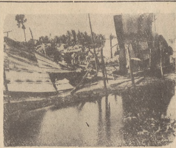
Zburzone domy w Noakhali po przejściu nad wschodnim Pakistanem cyklonu. 3.000 ludzi poniosło śmierć, a 90 procent domów, zbudowa- nych z pali bambusowych, krytych blachą, cyklon zrównał z ziemią
