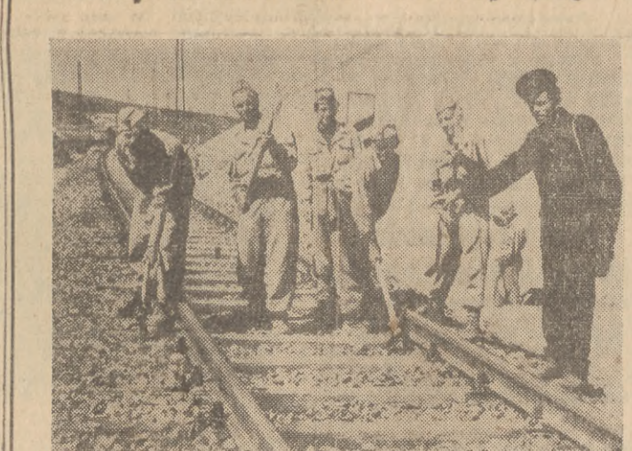
Ochotczy i z zapalem pracują junacy 18 brygady PO Służba Polsce przy budowie torów kolei elektrycznej, którą za niecałe 2 miesiące będziemy jeździć do Gdyni. Na zdjęciu: produkujący junacy z plutonu ob. Florkowskiego (trzeci od lewej) ubijają kamienie przy podkładach. Instruuje torowy, Franciszek Bork.
