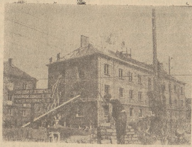
Robotnicy Zjednoczenia Budownictwa Gdańskiego budują bloki 22 i 20 na budowie nr 37 zaciąganej warty 1-majowej, zobowiązując się oddać do użytku na 30 dni przed terminem 28 Izb Mieszkalnych. Na zdjęciu: Murarze J. Belz i W. Bogdziewicz przy mrowaniu fundamentów nowego budynku. W głębi bloki 20 i 22. CAF fot. Uklebiński
