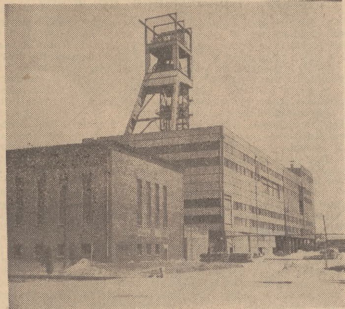
Jedną z większych inwestycji Planu 6-letniego jest budowa kopalni mikołowskiego zagłębia — Ziemowit II. Kopalnia ta należy do najnowocześniejszych zakładów tego typu. W Ziemowicie II od dawna już wydobywa się węgiel, budynki zaś w miarę wykańczania oddawane są sukcesywnie do użytku. Na zdjęciu: Ogólny widok głównego szybu wyciągowego i budynku, w którym mieści się nowoczesna hala sortownicza. CAF — fot. Baranowski
