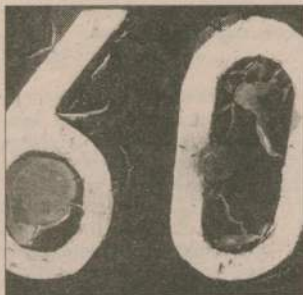
Zniszczenie farby na tablicach może spowodować mycie pod ciśnieniem oraz zmiany temperatury.
