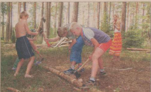
Podczas pierwszych dni pobytu obóz zamienia się w plac budowy. Harcerze samodzielnie zbudowali m.in. prycze, prysznice i stoły.
