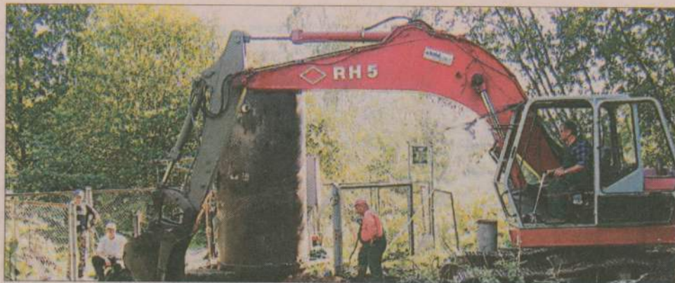
Skanalizowanie kolejnych miejscowości gminy było jednym z głównych zadań inwestycyjnych ostatnich lat. Na zdjęciu przepompownia w Rzeczenicy.
