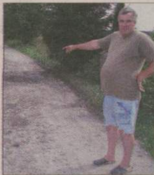
Drogę czeka jednak poważniejszy remont - ma być utwardzona i zrobiona nowa nawierzchnia.
