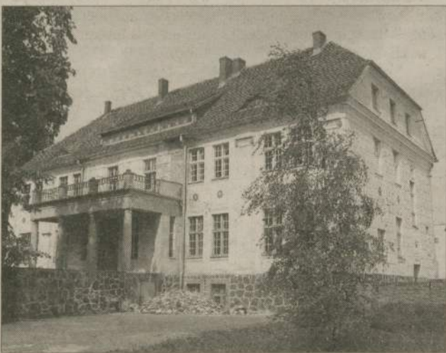
Trwa remont pałacu - najcenniejszego zabytku Dąbrowy.
