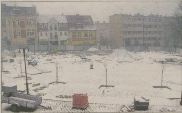
10 sierpnia 2005 na plac wjechali pierwsi pracownicy. Ogrodzili teren, zdjęli asfalt. Do września zdjęto płytki chodnikowe i warstwę starobruku. Rynek miał być gotowy do końca października. Ale pierwszy śnieg sygnalizował wciąż nieukończony plac. Kiedy mróz dobrze ścisnął prace trzeba było przerwać.
