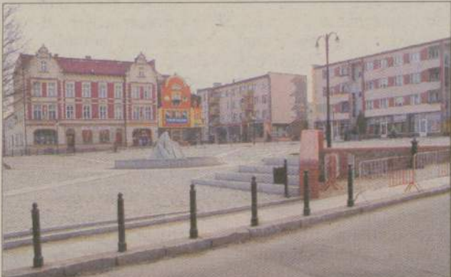
Na ile rynek po liftingu przypomina ten z projektu każdy może ocenić sam. Na stronie www.czulchow.naszemiasto.pl przywróciliśmy uaktualnioną galerię zdjęć z całego przebiegu prac pod nazwą „Na Rynku”
