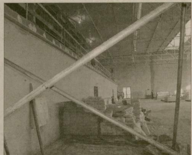
Jeszcze niespełna dwa miesiące i hala powinna być gotowa...
