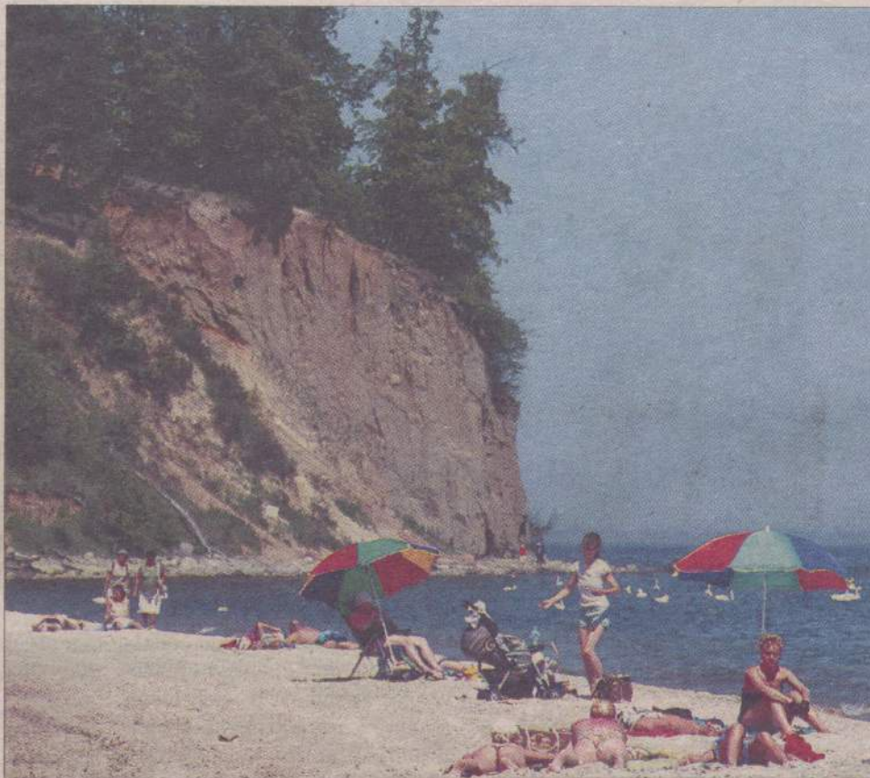
Zabezpieczenia brzegu osłonią także klif w Orłowie.
