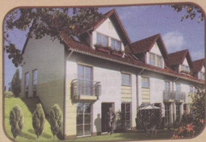
Osiedle Cztery Pory Roku - domy jednorodzinne Gdańsk, ul. Kolarska, Tenisowa
