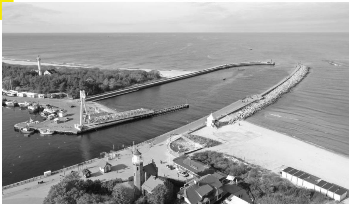
W ramach wsparcia morskiej energetyki wiatrowej usteckie falochrony przejdą całkowitą modernizację. Fot. Sławomir Lewandowski
