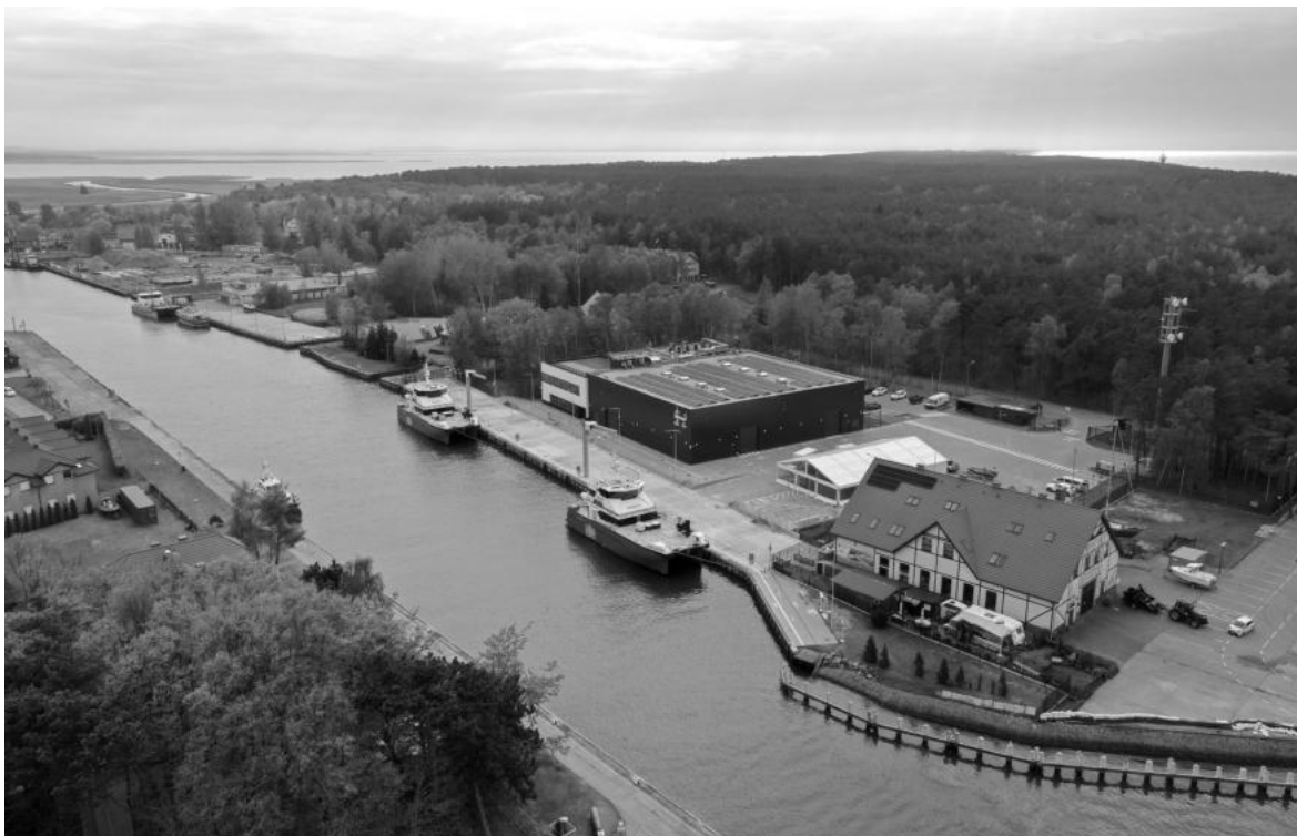
Baza operacyjno-serwisowa dla pierwszej morskiej farmy wiatrowej na polskich wodach Bałtyku. Fot. Sławomir Lewandowski
