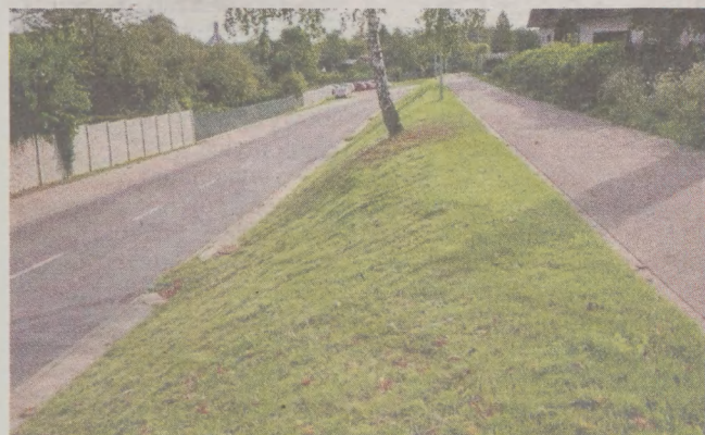
Ścieżka rowerowa przy ul. Legionów Polskich jest poprowadzona tuż obok skarpy opadającej w stronę jezdni
