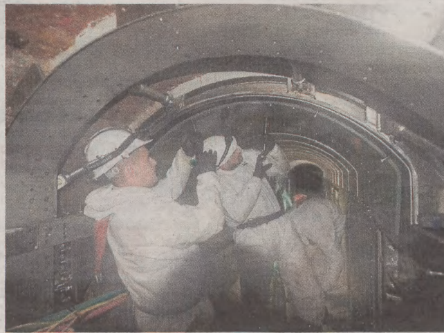
Prace w kanale burzowym pod Baker Street w Londynie
