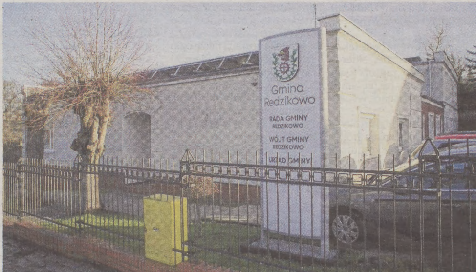
Przed budynkiem Urzędu Gminy Słupsk przy ul. Sportowej w Słupsku staną już „witacz” z nową nazwą gminy - Redzikowo
